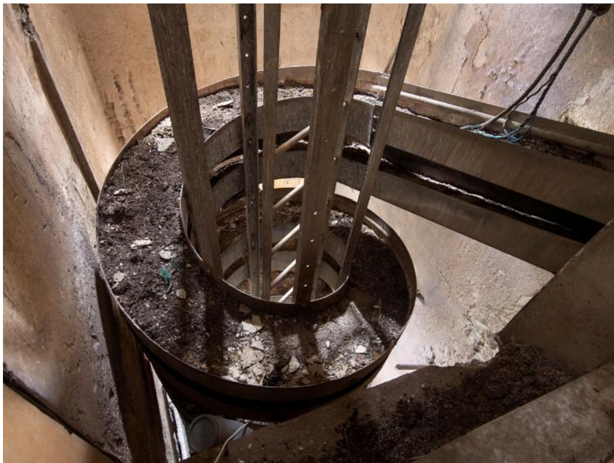
Toboggan depuis le compresseur de glace (tour sud-ouest)
