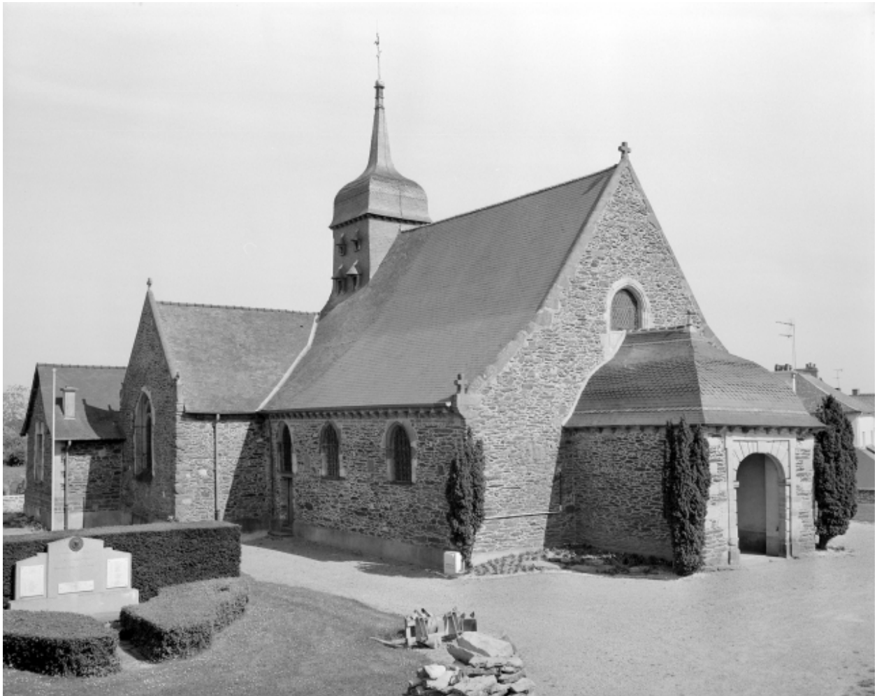
Elévation Nord-Ouest : vue générale (état en 1994)
