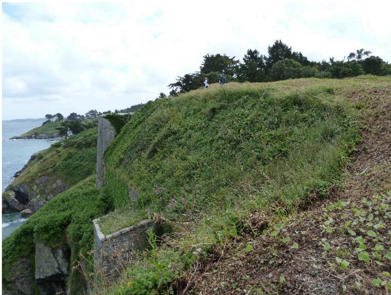
Le Palais, enceinte urbaine, courtine 18, extrémité nord-est.
