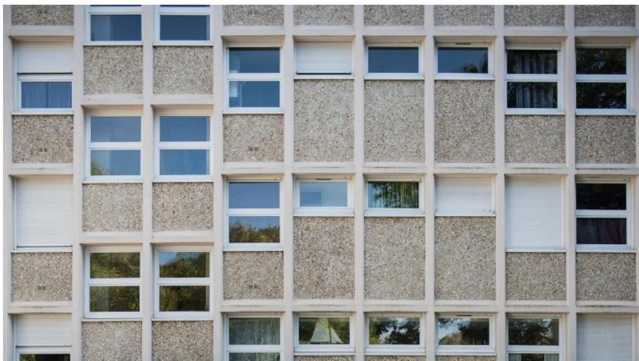
Bâtiment E (internat à l'origine), façade ouest, détail sur la trame de 1,75 m et les différentes hauteurs des allèges.
