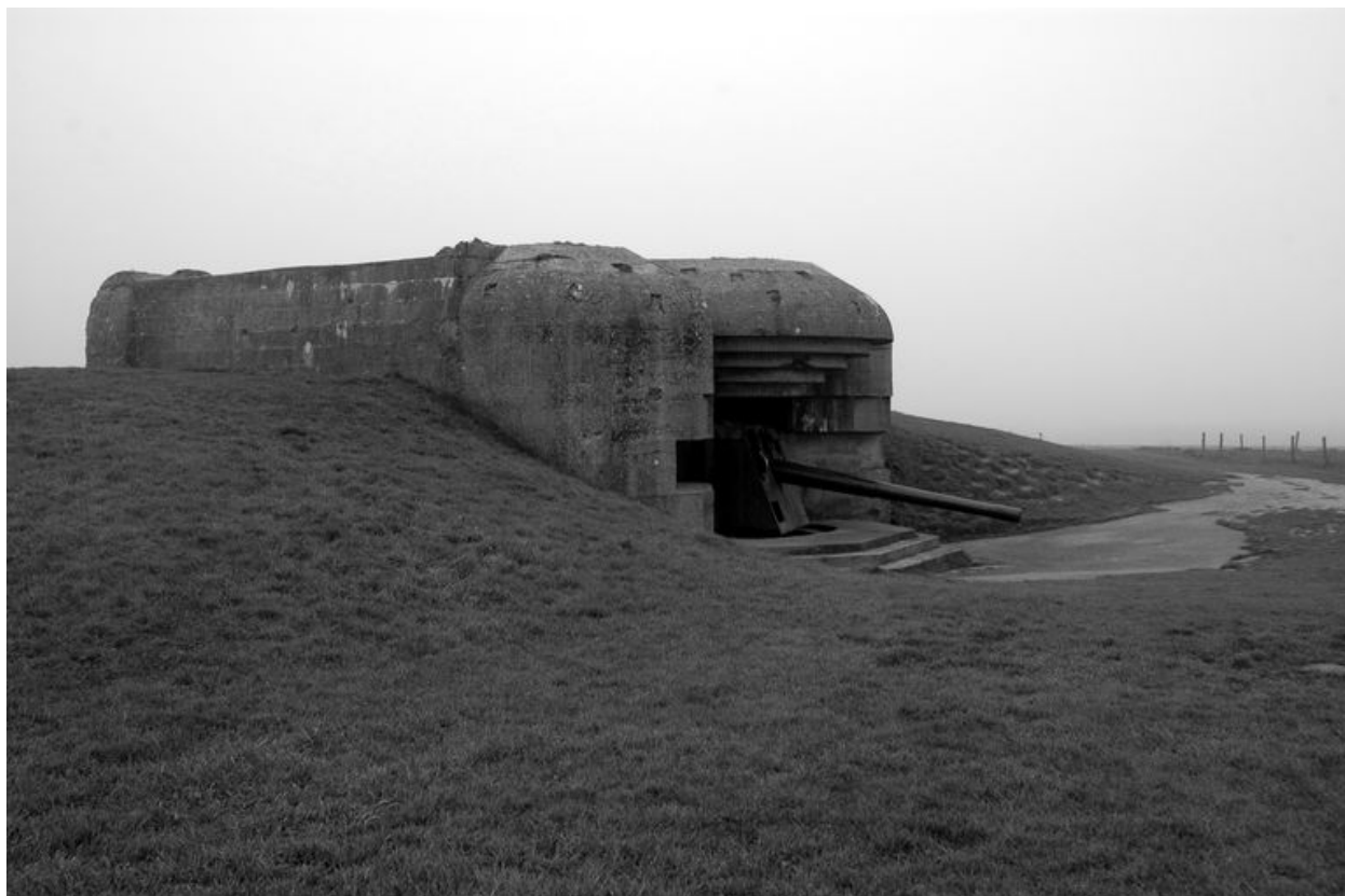
Vue générale de l'une des quatre casemates de la batterie de Longues-sur-Mer (casemate n° 2 depuis l'est)
