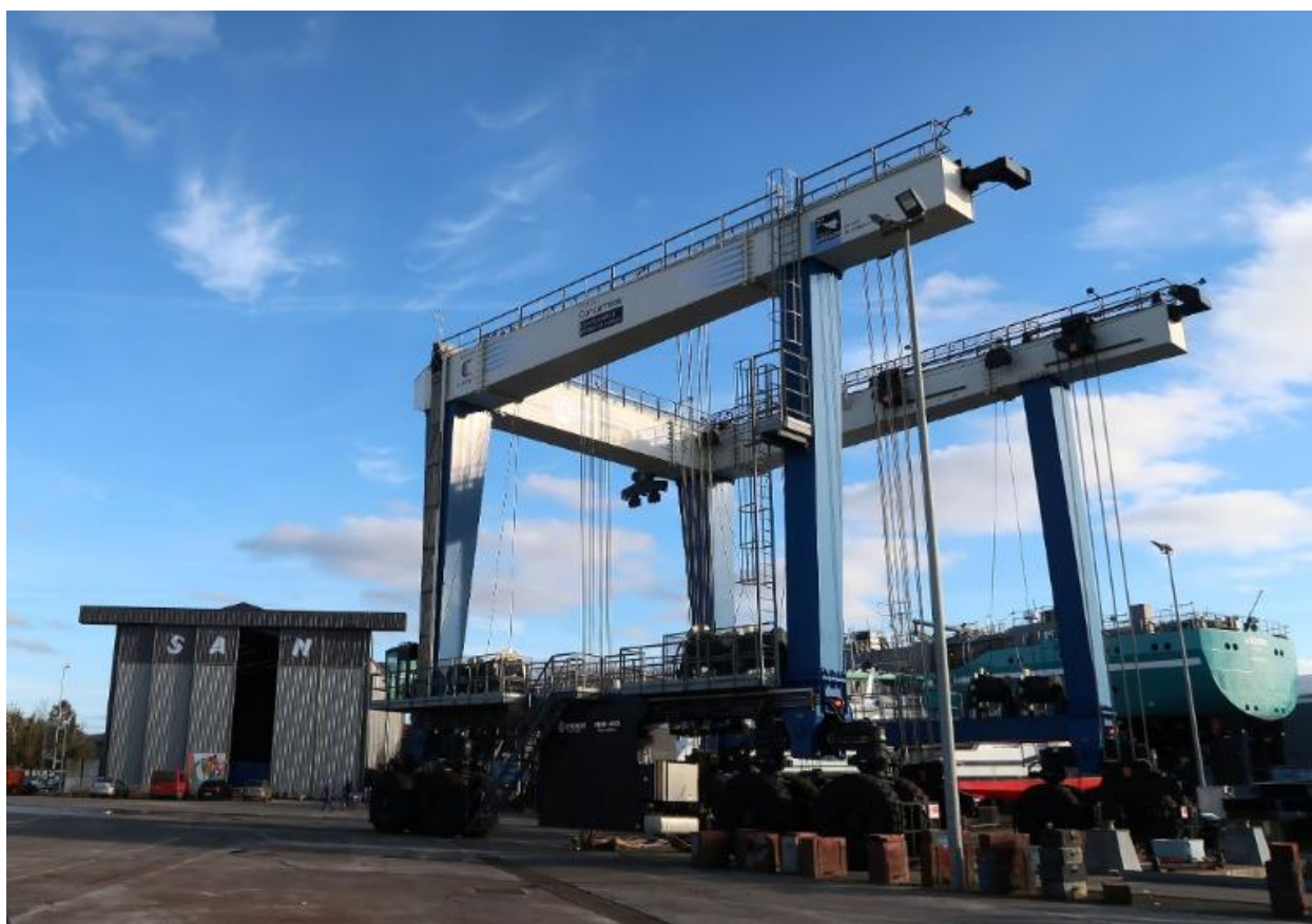
Aire de réparation navale : élévateur à bateaux
