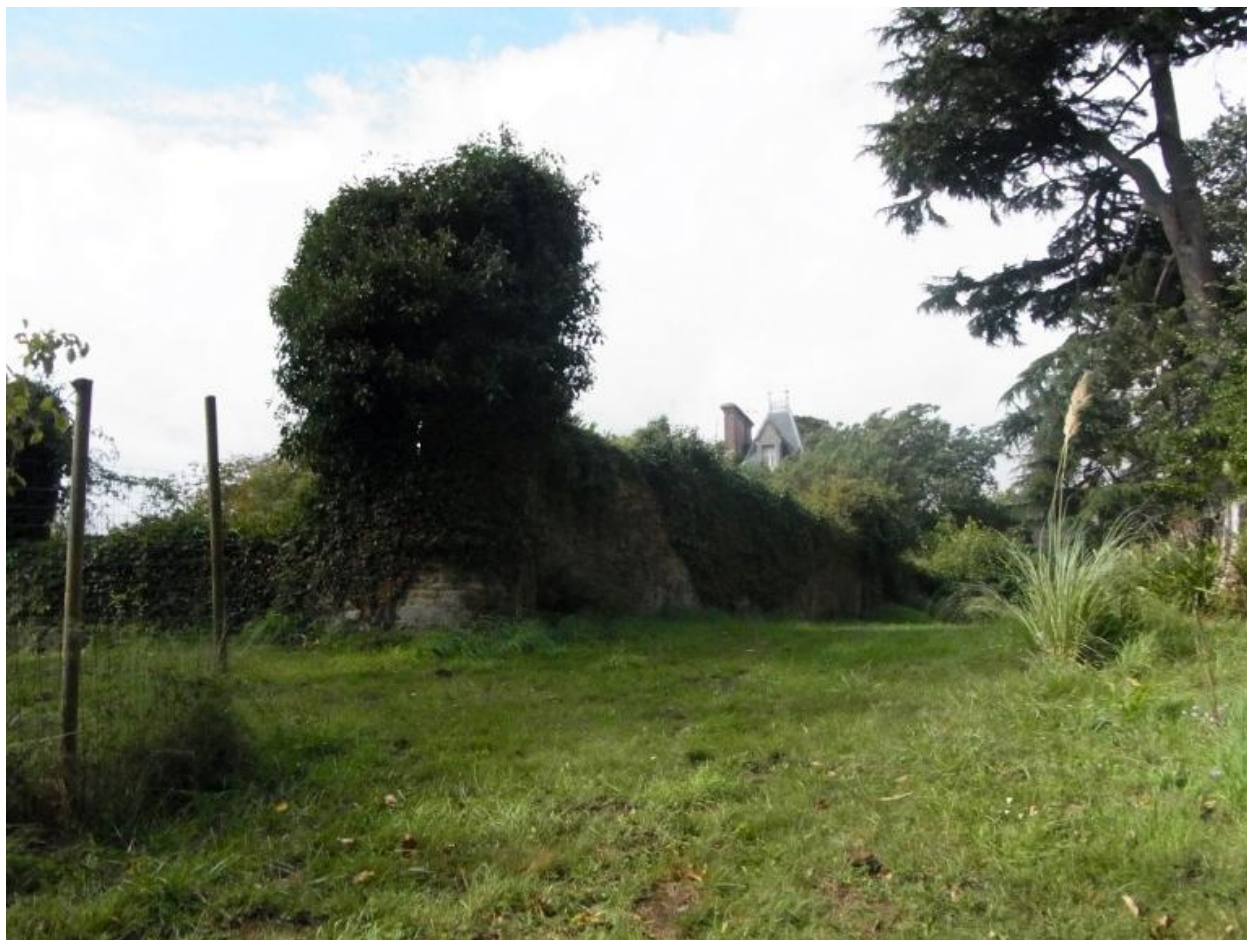
Enclos du jardin, avec tourelle d'angle en ruines
