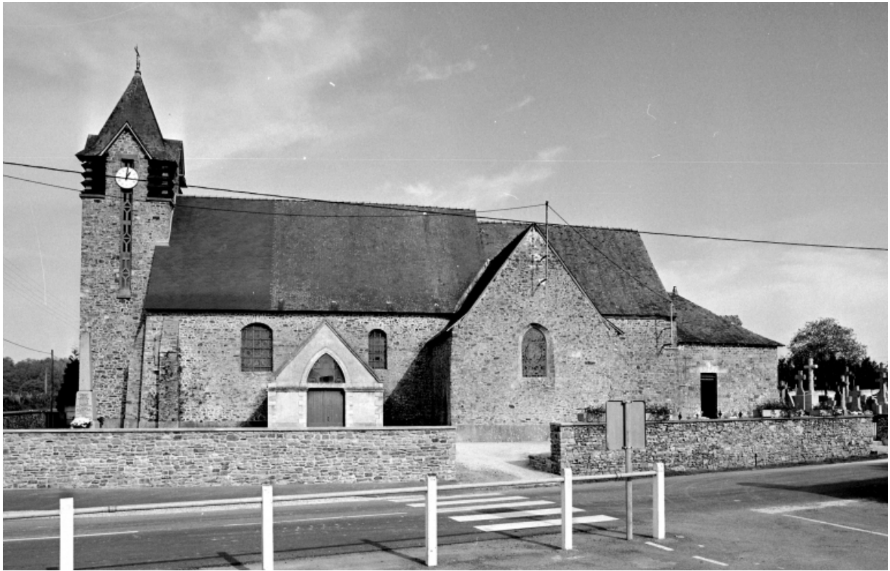
Elévation sud : vue générale
