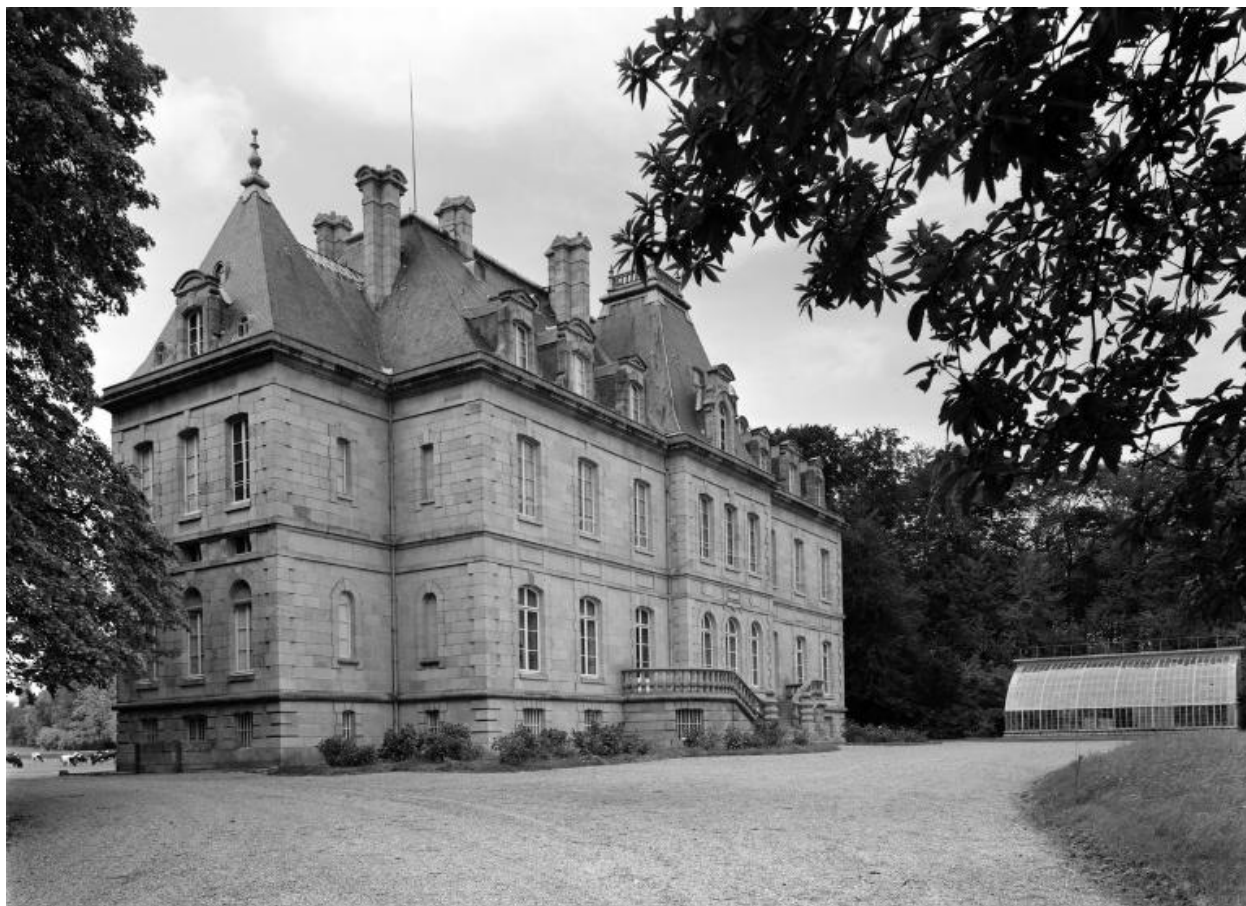
Logis, élévation sud-est et serre, vue générale
