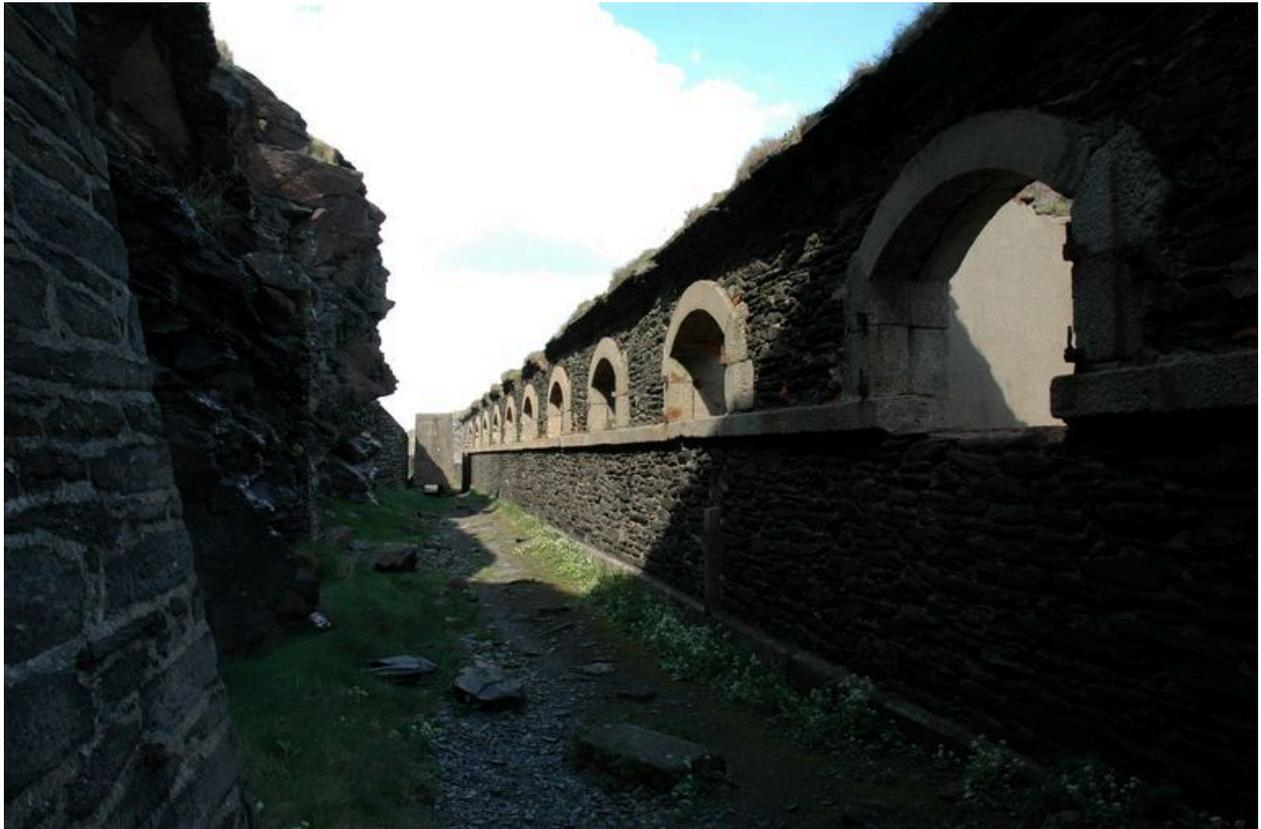
Vue du passage situé entre le rocher et la caserne. Les baies sont voutées en segment à claveaux. A l'extérieur, l'appui, les piédoits et l'arc sont en granite
