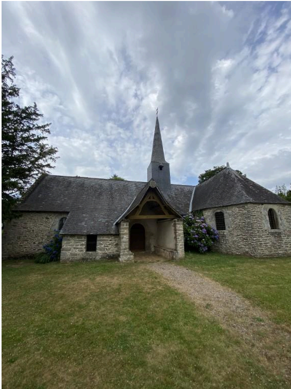
Vue générale sud
