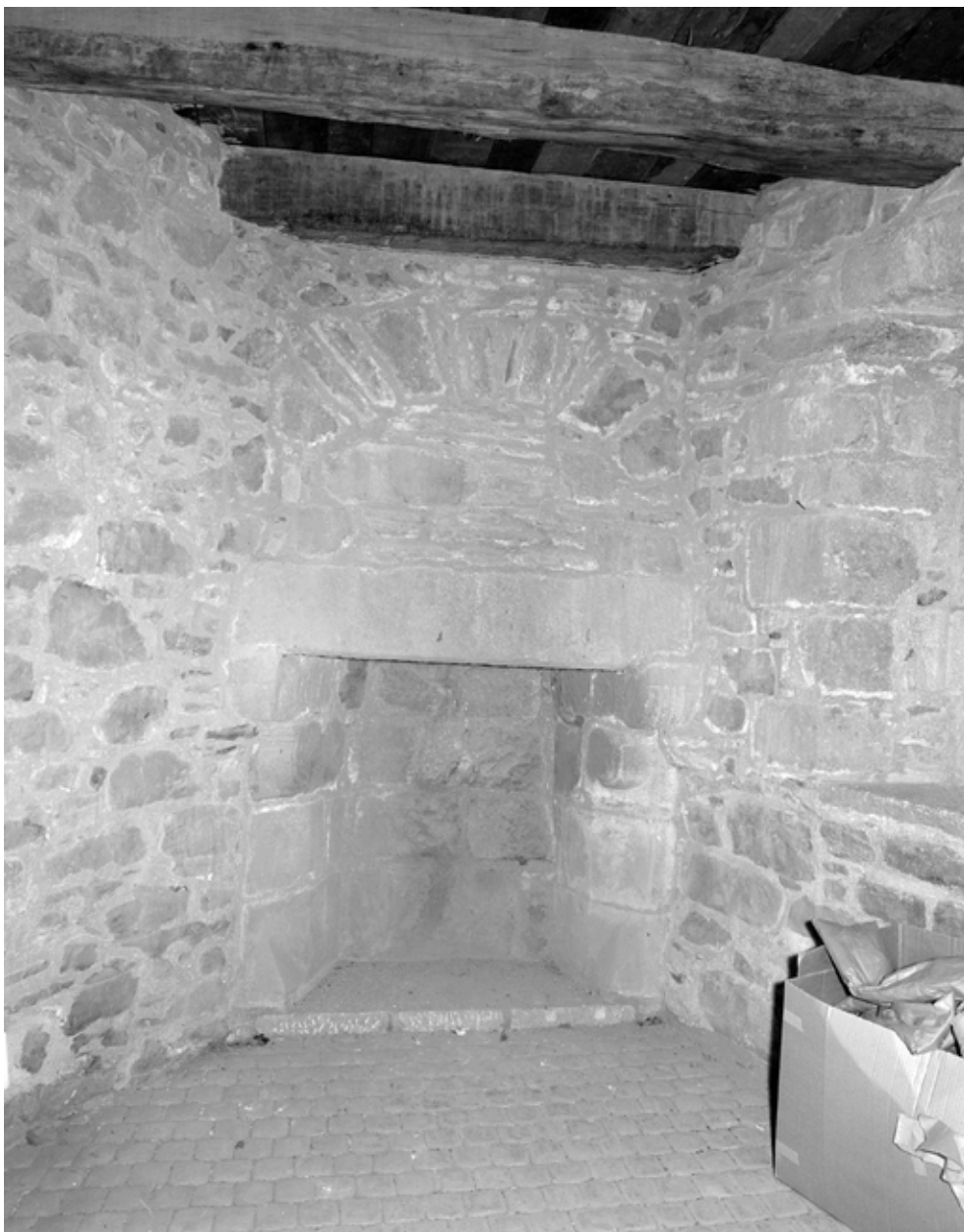
Vue du corps de garde du chemin de ronde : cheminée (état en 1974)
