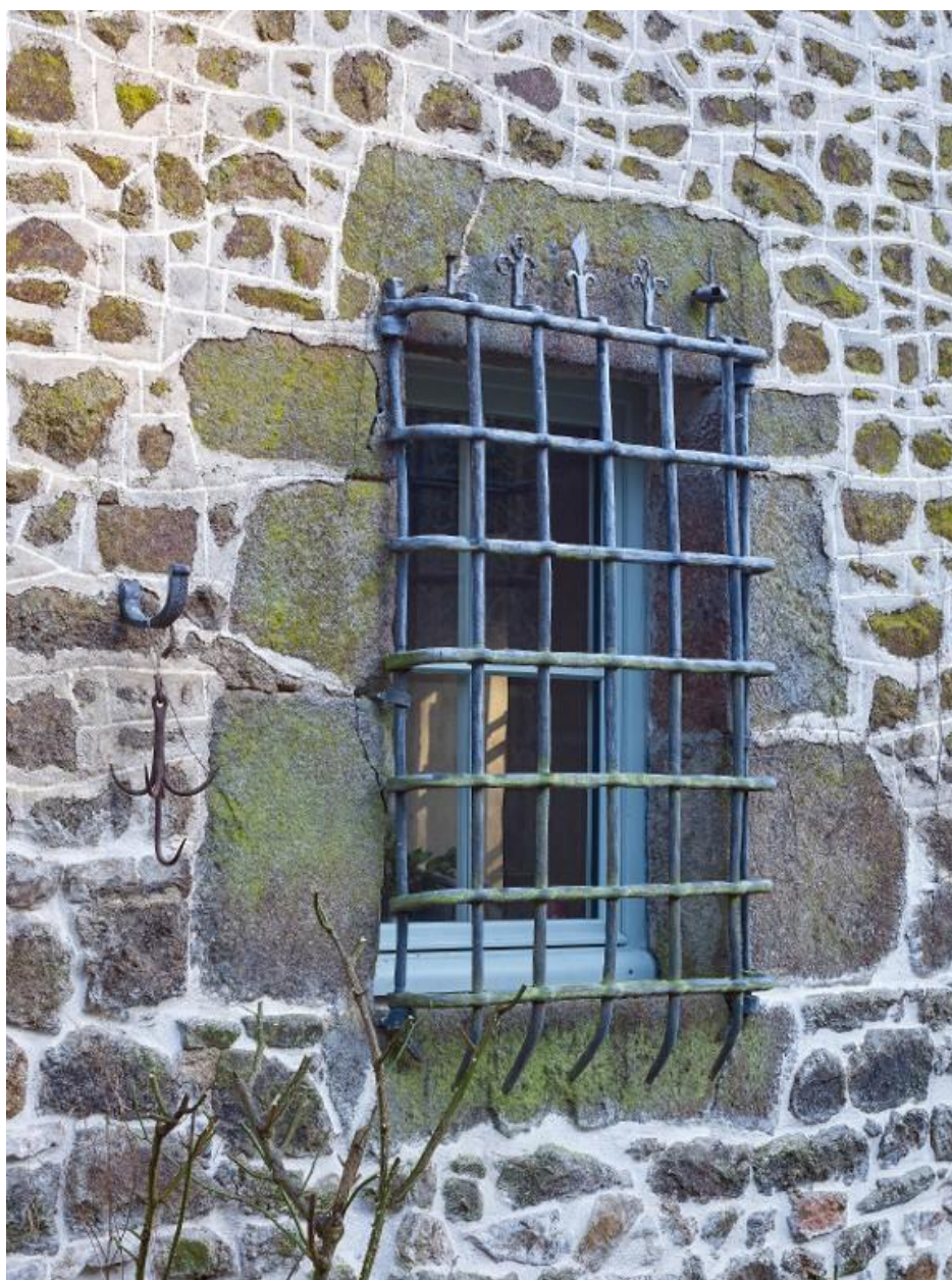
Façade sud. Salle est. Fenêtre protégée par une grille en fer forgé
