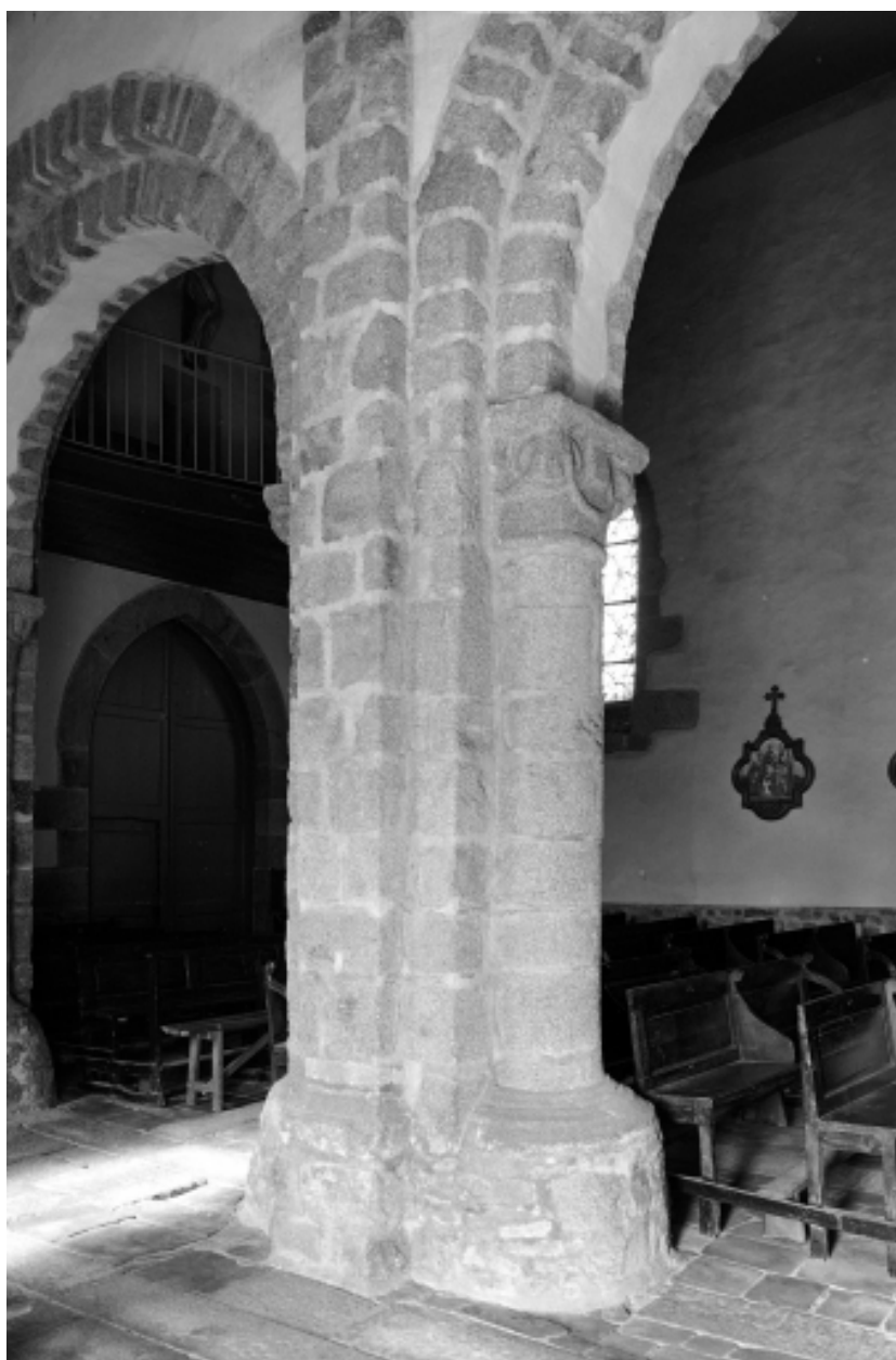
Intérieur, pile n°1 : vue générale.
