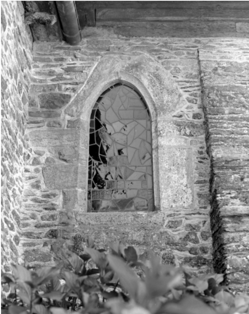
Elévation nord, détail de la petite fenêtre.
