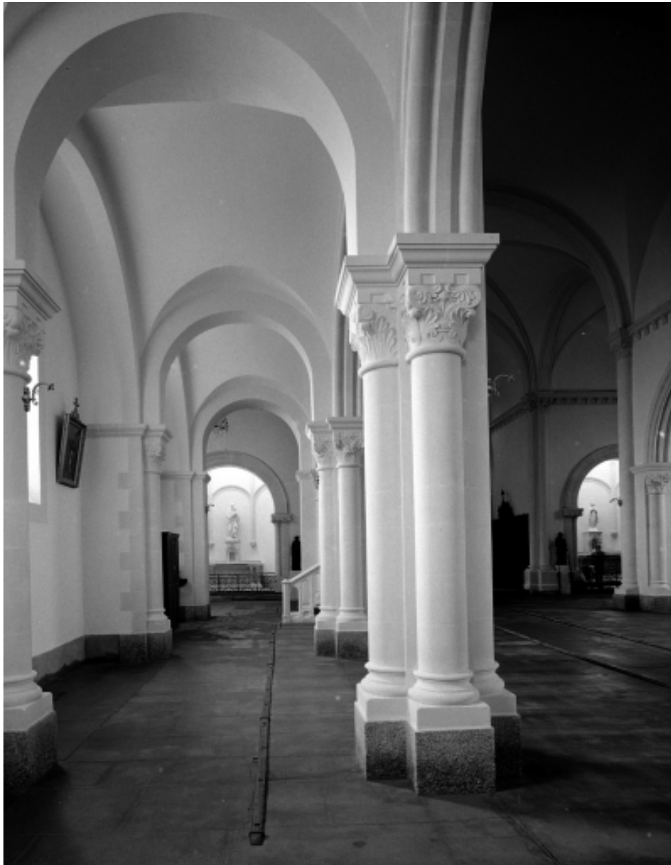
Intérieur, nef, bas-côté Nord : vue Ouest-Est.
