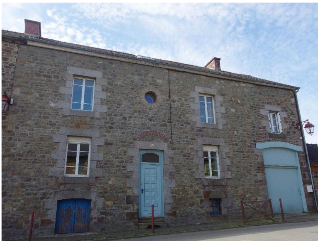
Vue de la façade nord
