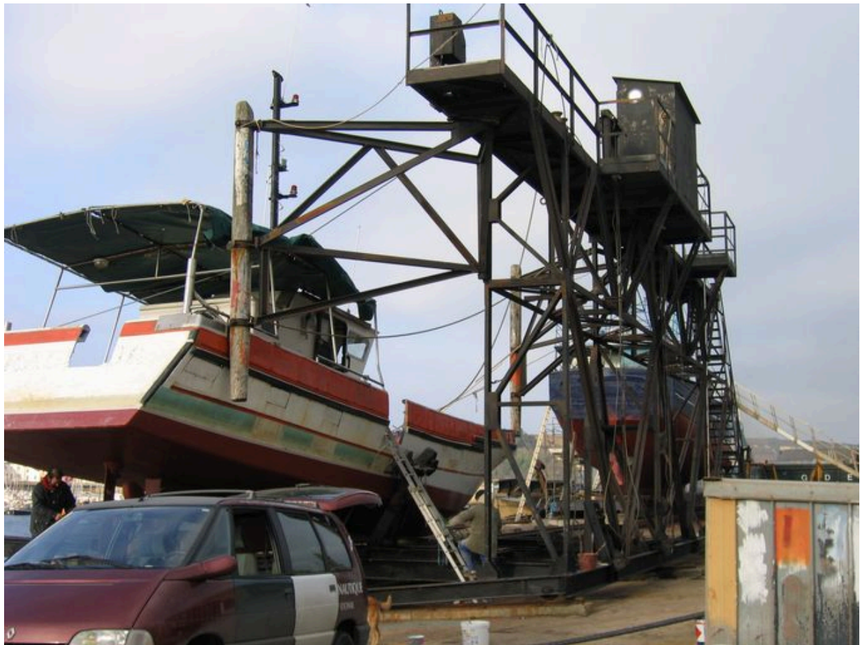
Partie haute du slipway avec treuil à bateau
