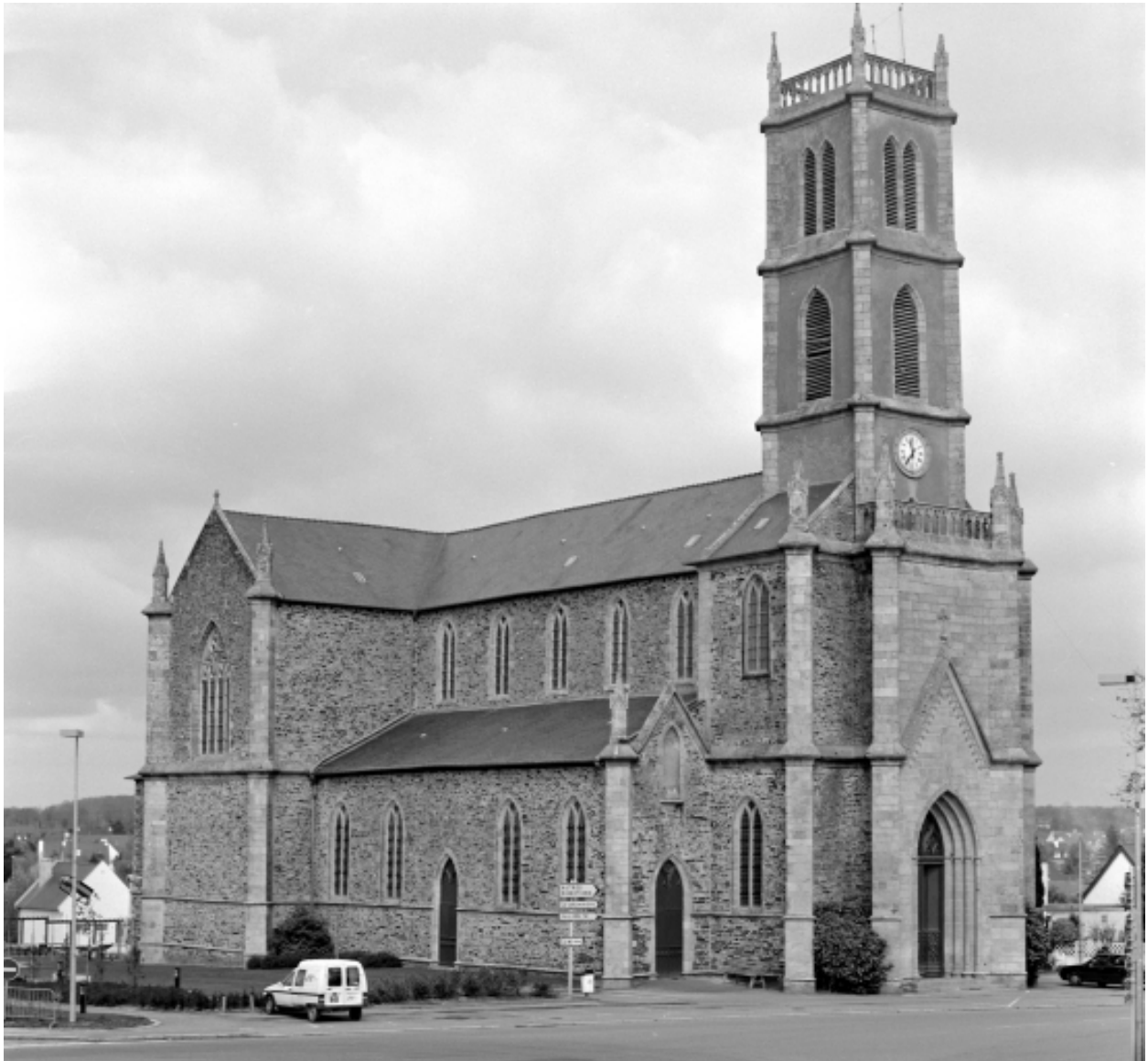
Elévation Nord-Ouest : vue générale
