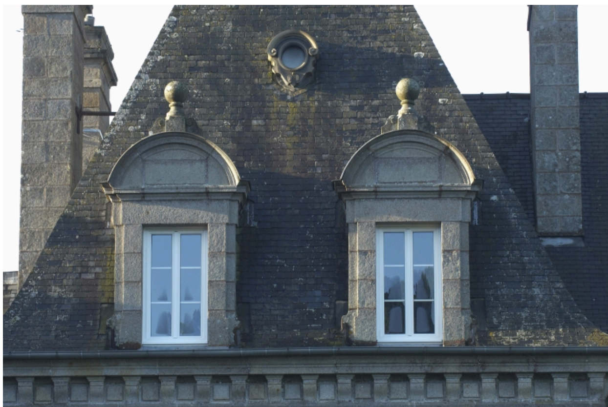
Détail des baies du pavillon sud-ouest
