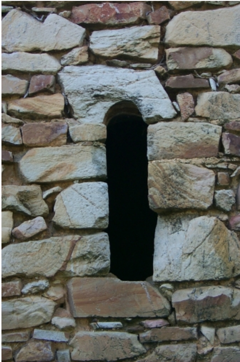
Nef, mur nord, détail baie
