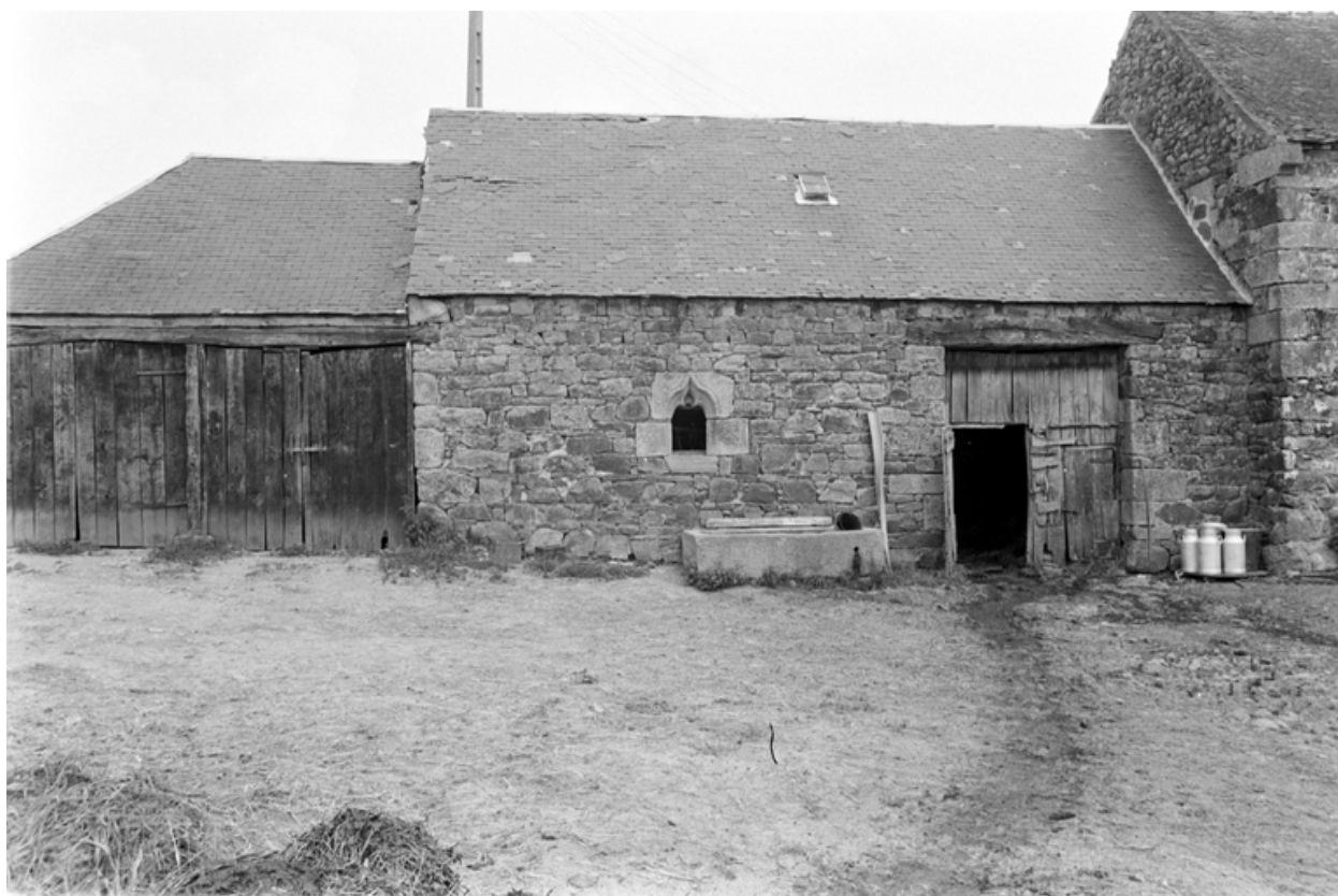
Vue de la façade sud de l'étable
