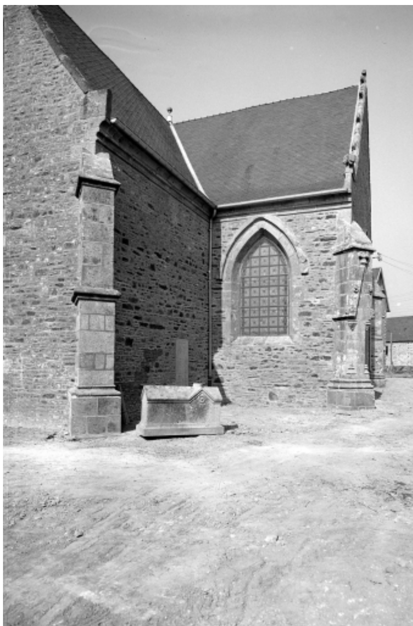
Façade sud, mur sud du choeur.
