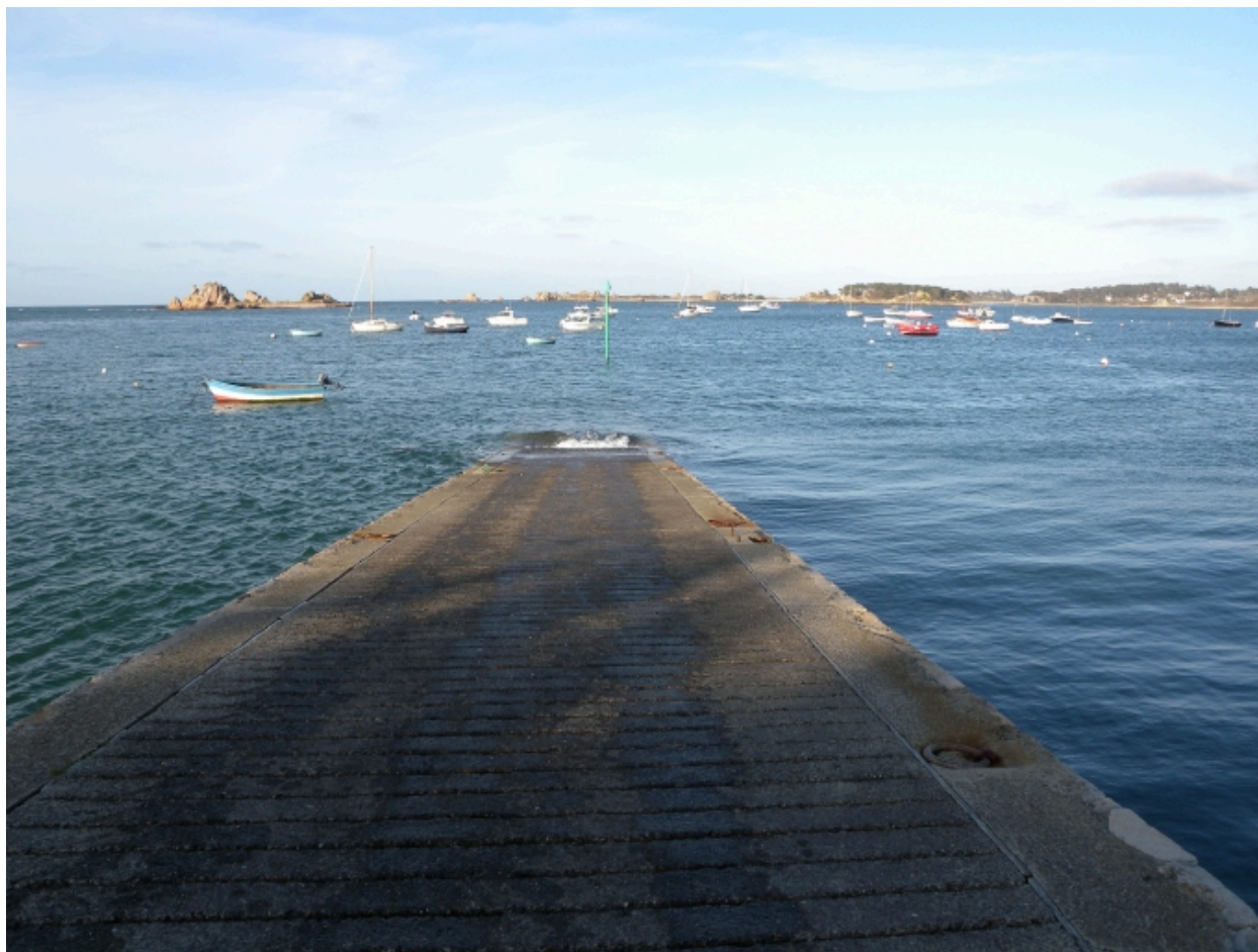
Vue du vaigrage en ciment de la cale
