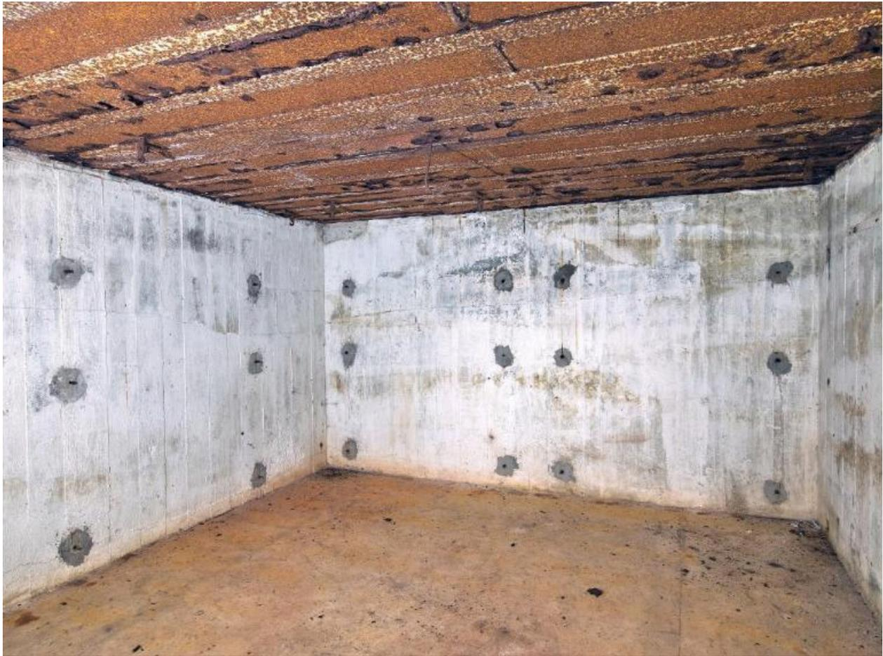
Vue de la salle de garde sud, traces des fixations des couchettes tubulaires (superposées par ensemble de 3). Au plafond subsistent les crochets pour les chaînes de suspension
