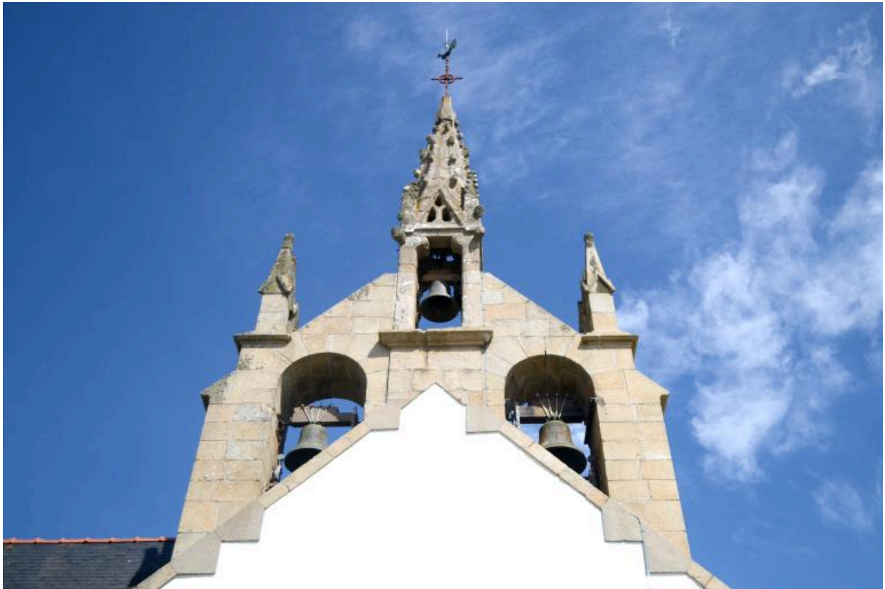
Détail du clocher, côté ouest. (2020)
