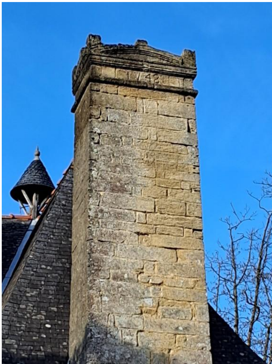
Pavillon, souche de cheminée en pierre de falun : date portée 1748
