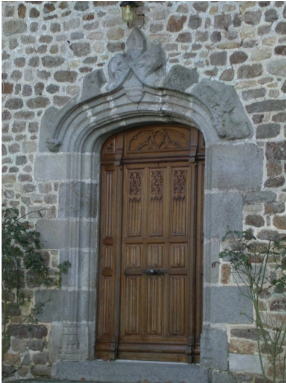
Détail de la porte d'entrée
