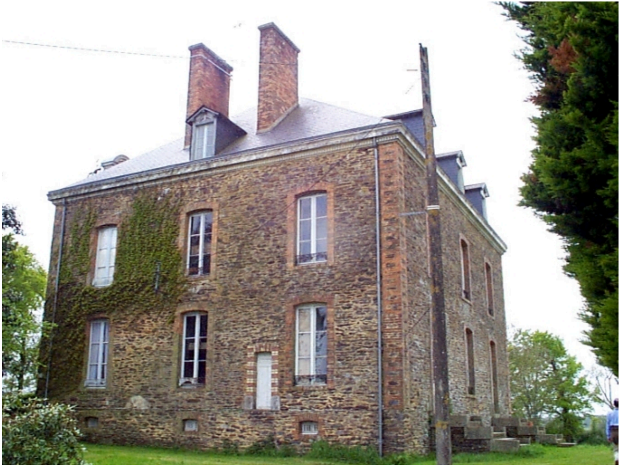
Pignon est : vue générale
