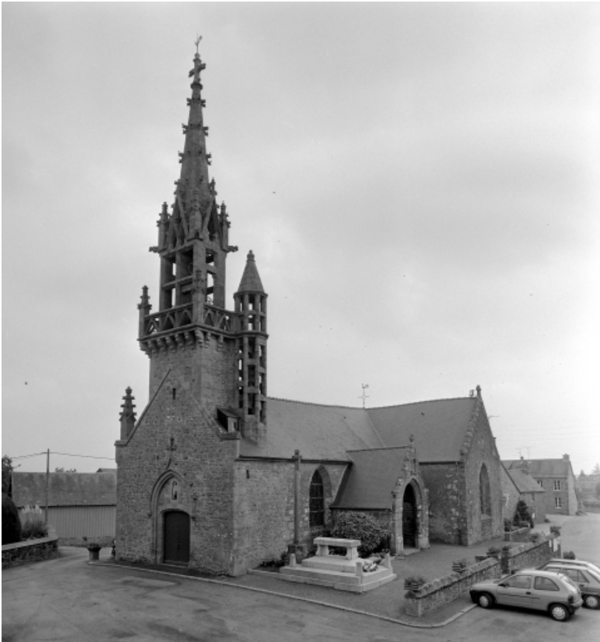
Elévation Sud-Ouest : vue générale
