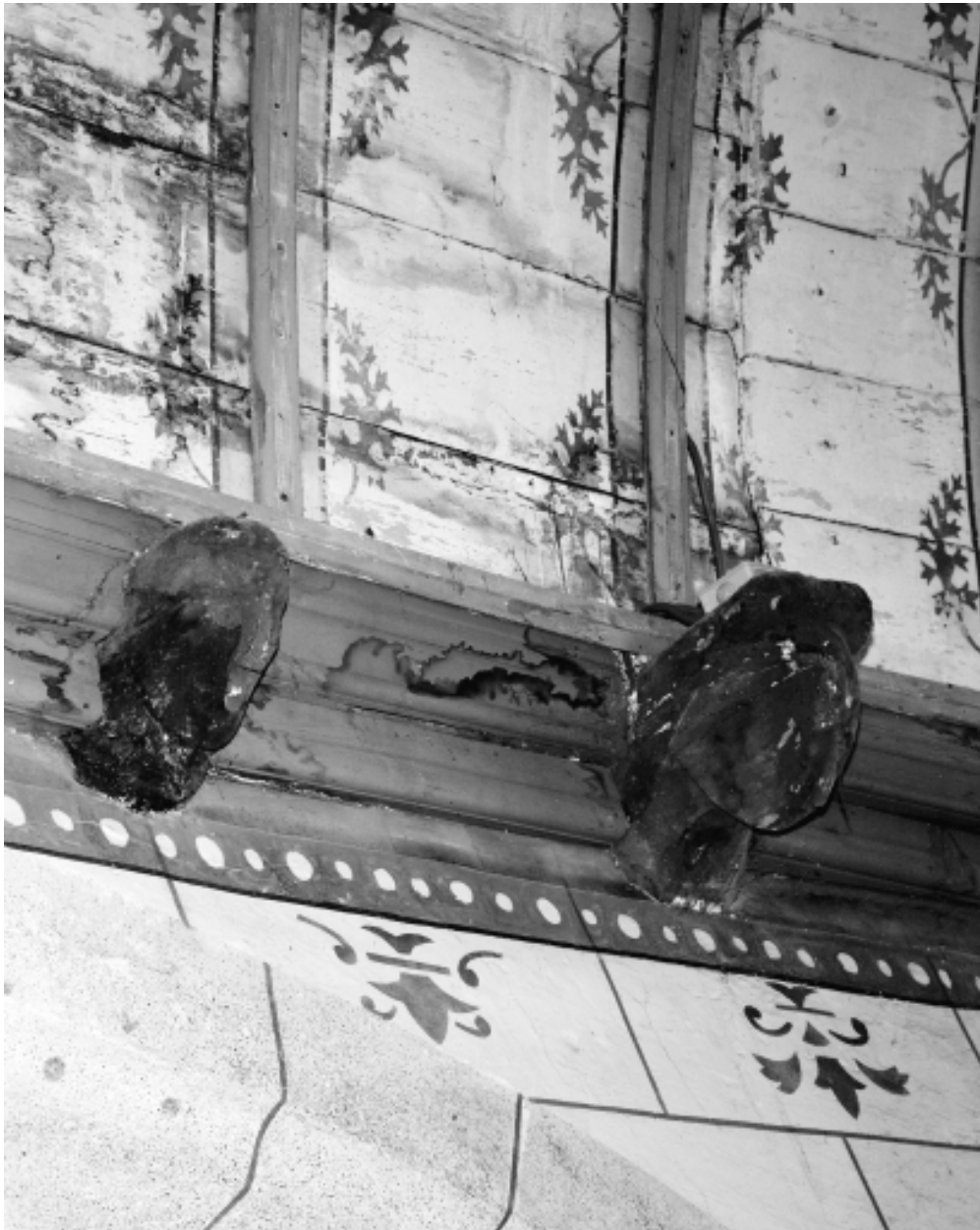
Sablières : vue de détail.
