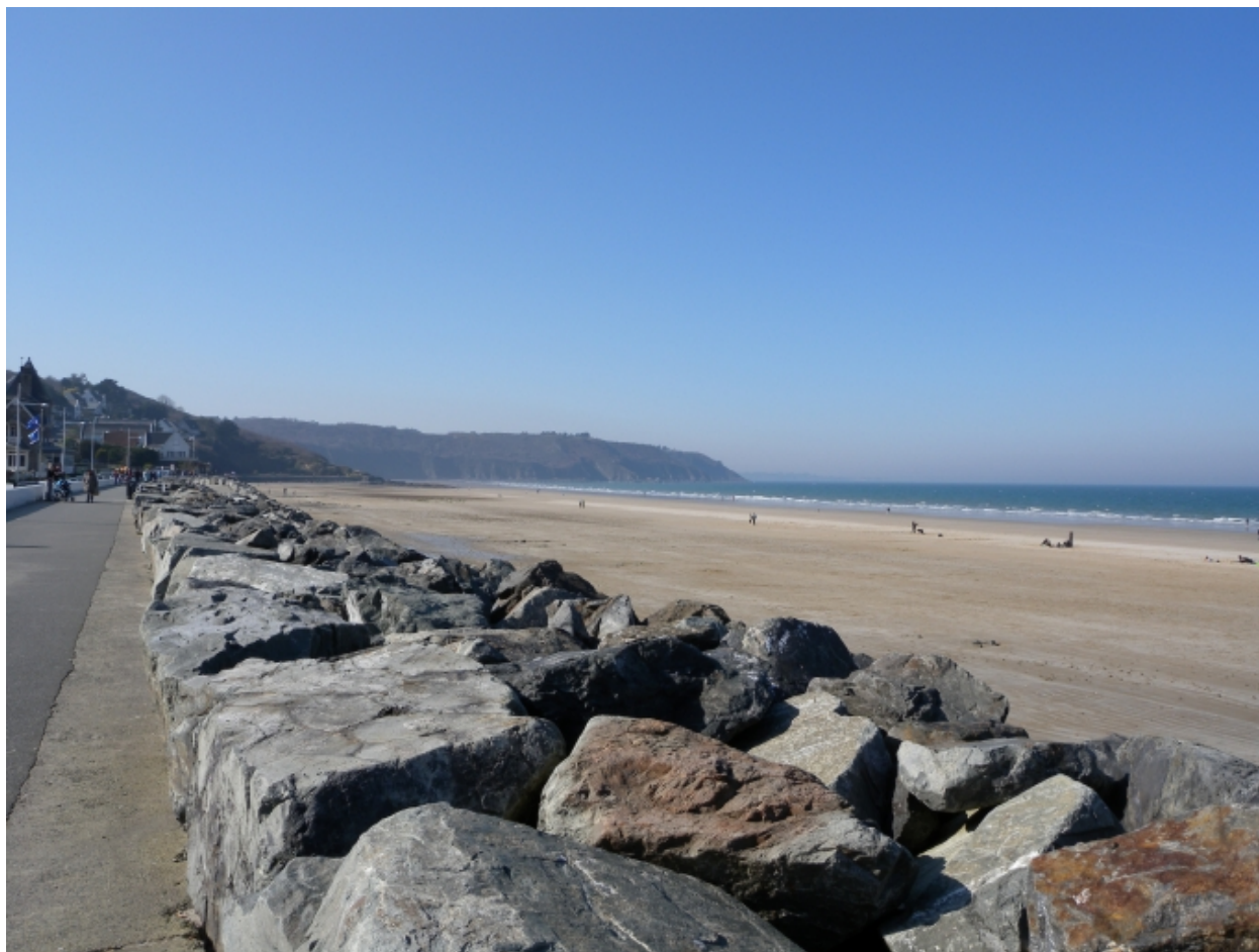
Vue des enrochements devant la digue-promenade
