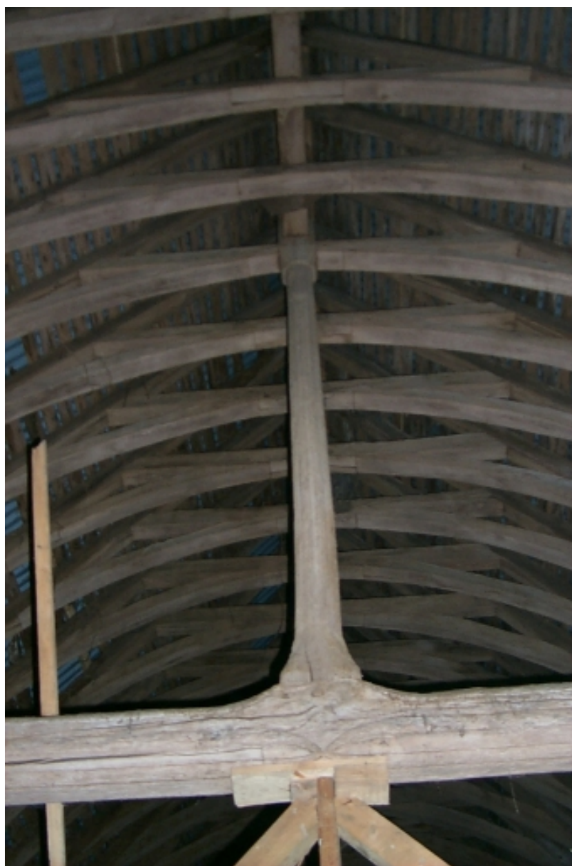
Intérieur, charpente, vue partielle
