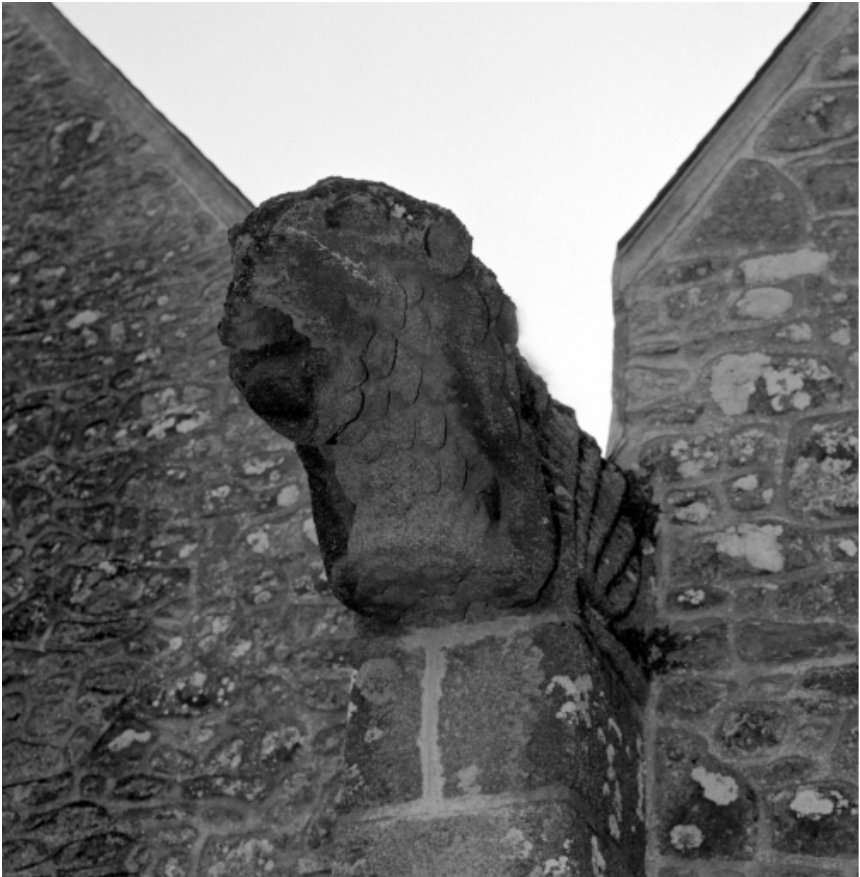
Élévation Nord, gargoille : détail de la face Ouest
