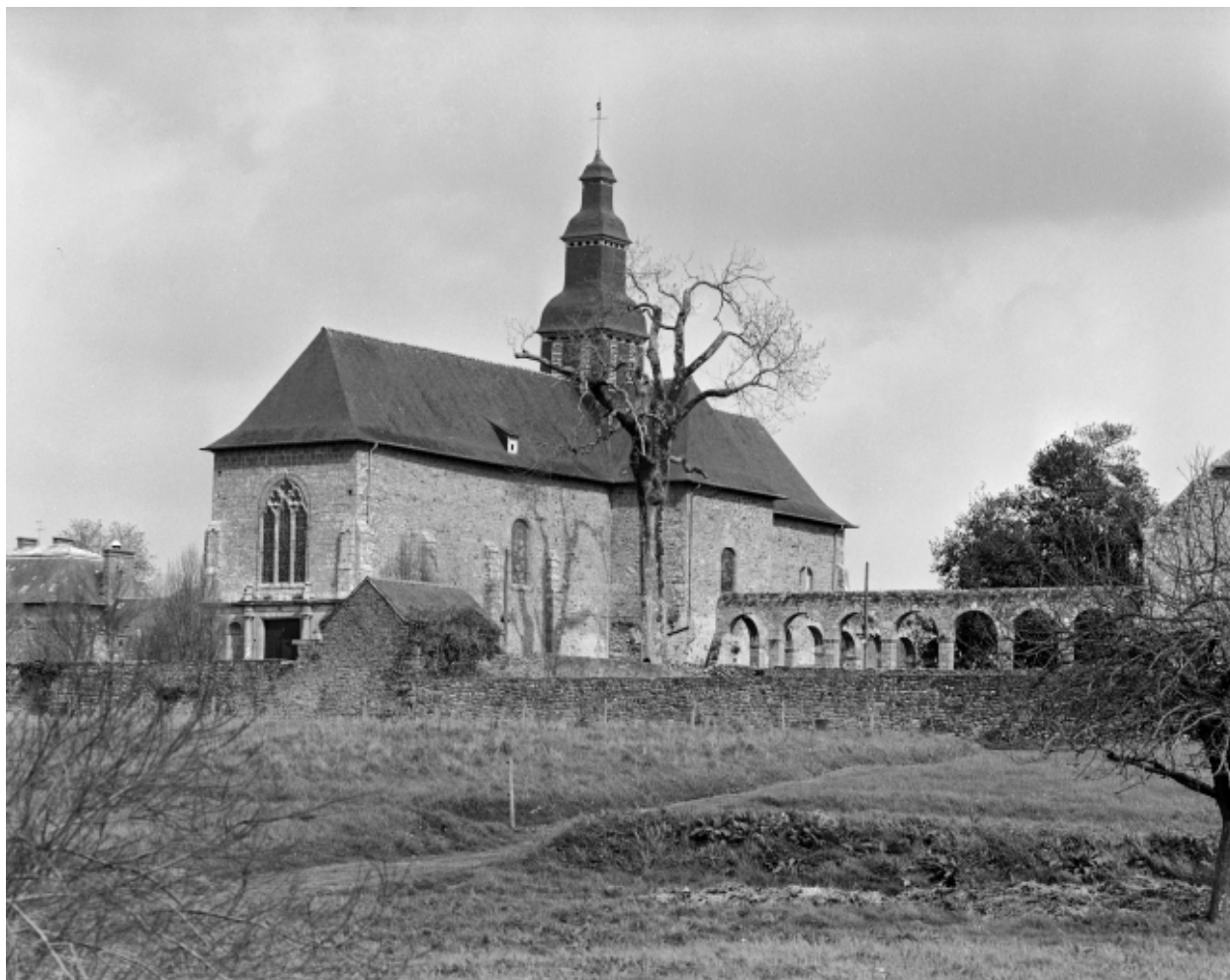
Elévation Sud-Ouest : vue de situation
