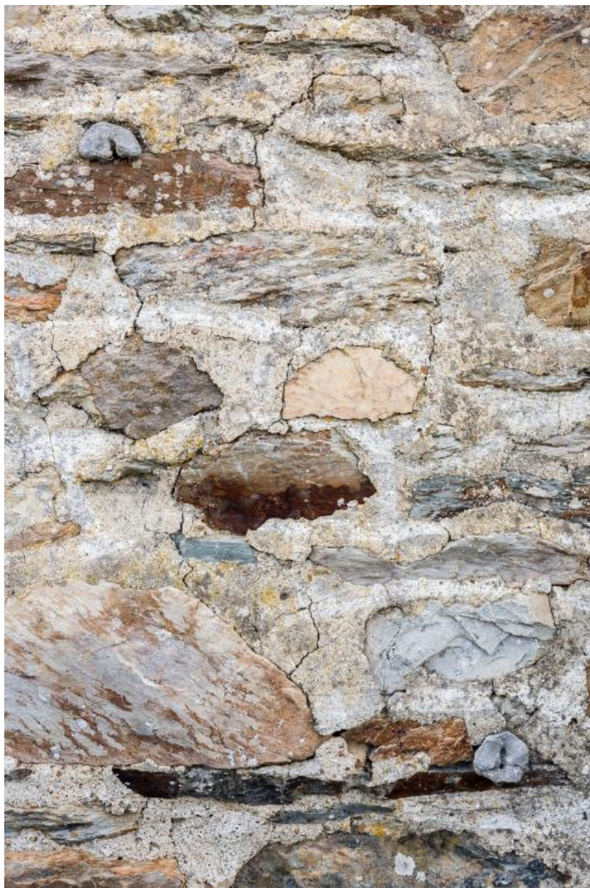
Etable, élévation nord-est, détail de l'appareillage ( os diposés en boutisses)
