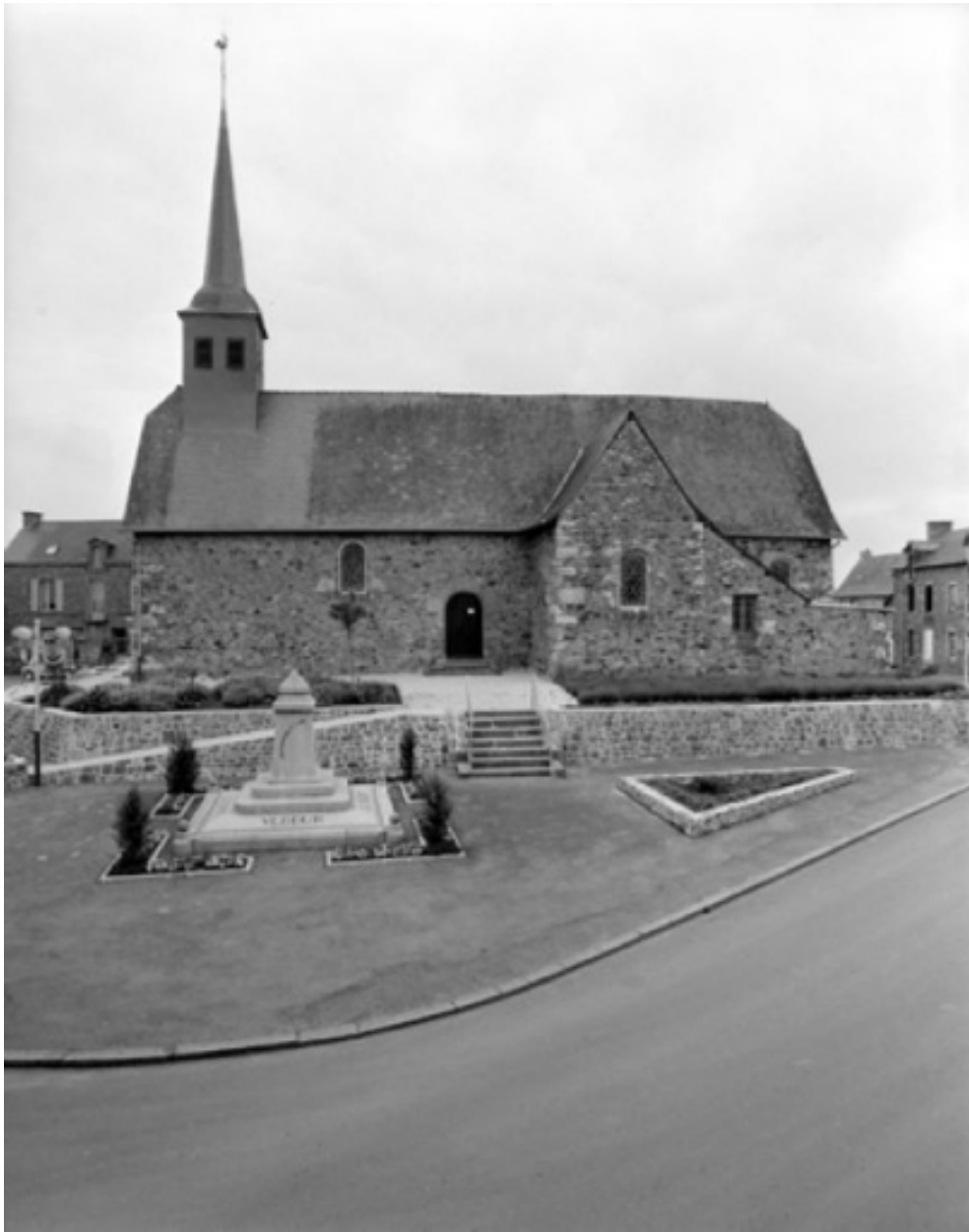
Elévation sud : vue générale
