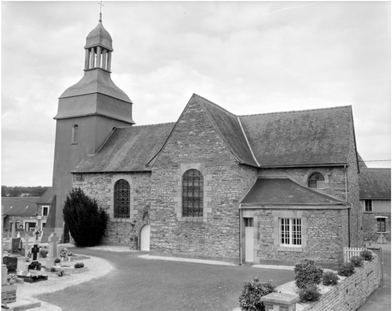
Elévation Sud : vue générale
