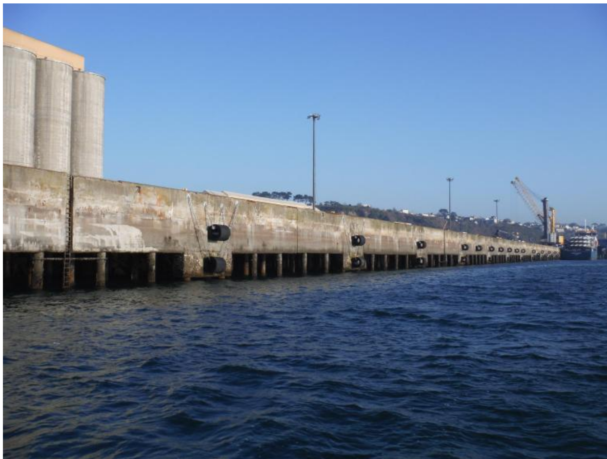
Plate-forme multimodale vue générale
