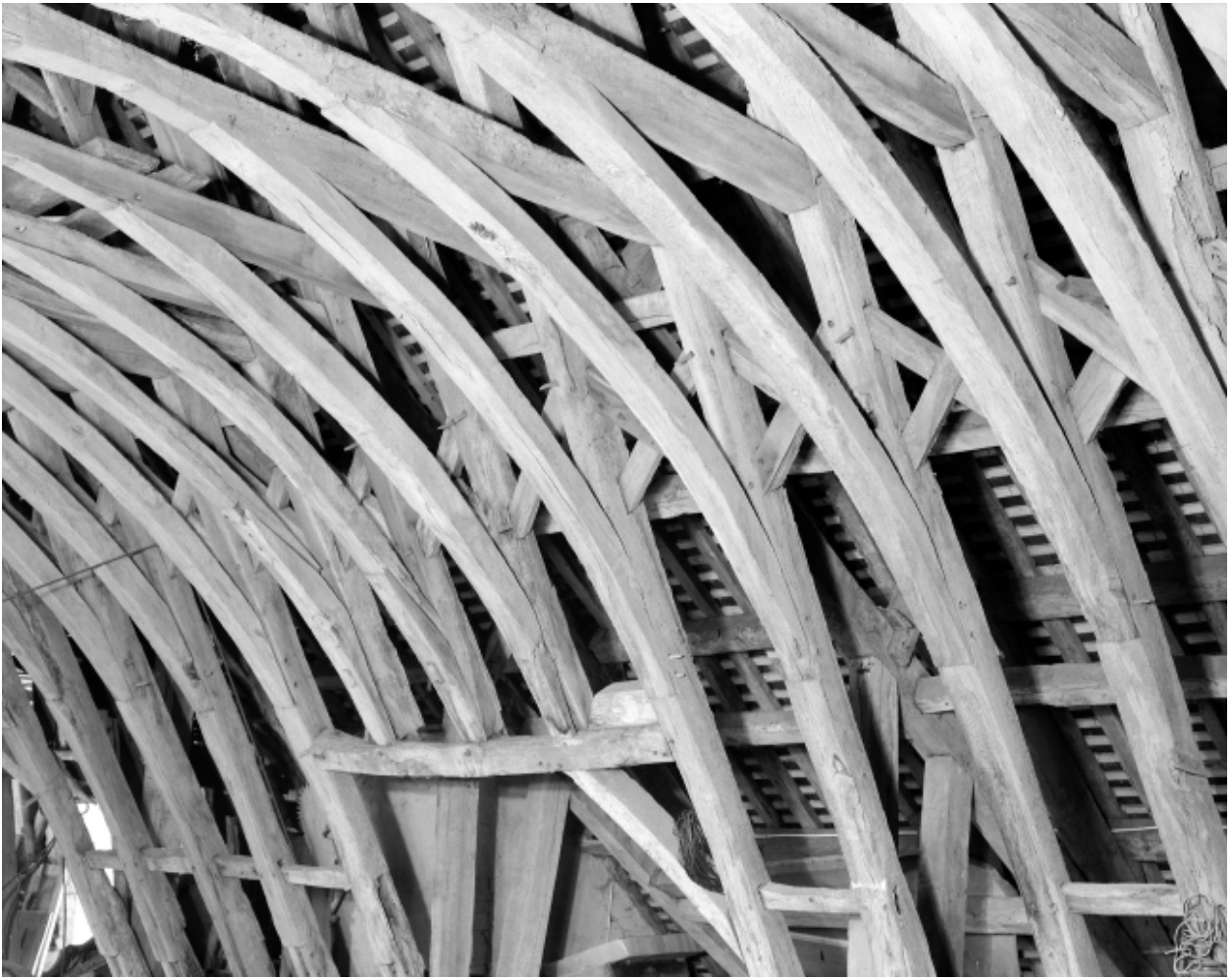
Charpente : détail chevrons, vue biaisée.
