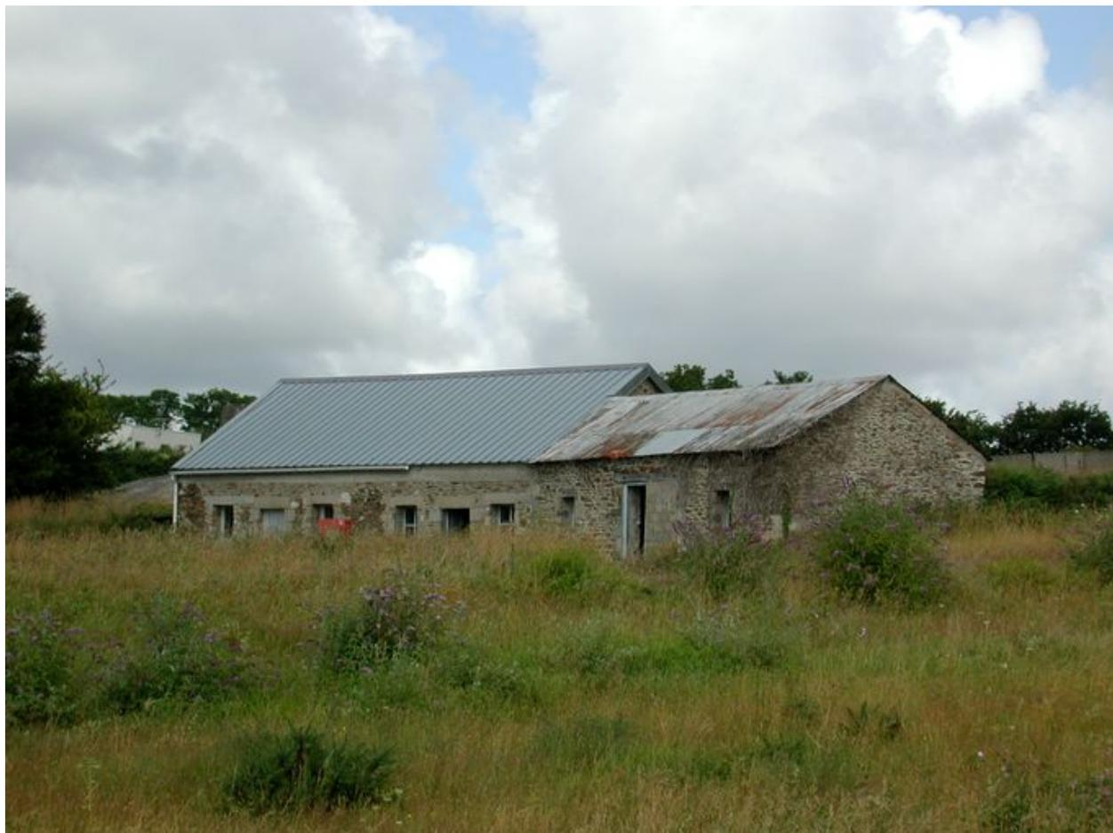
Vue d'un bâtiment en moellon (entourage des ouvertures en granite)
