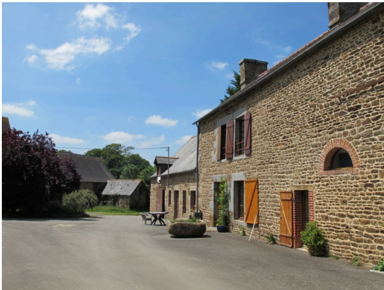
Ferme de l'Airie, vue générale
