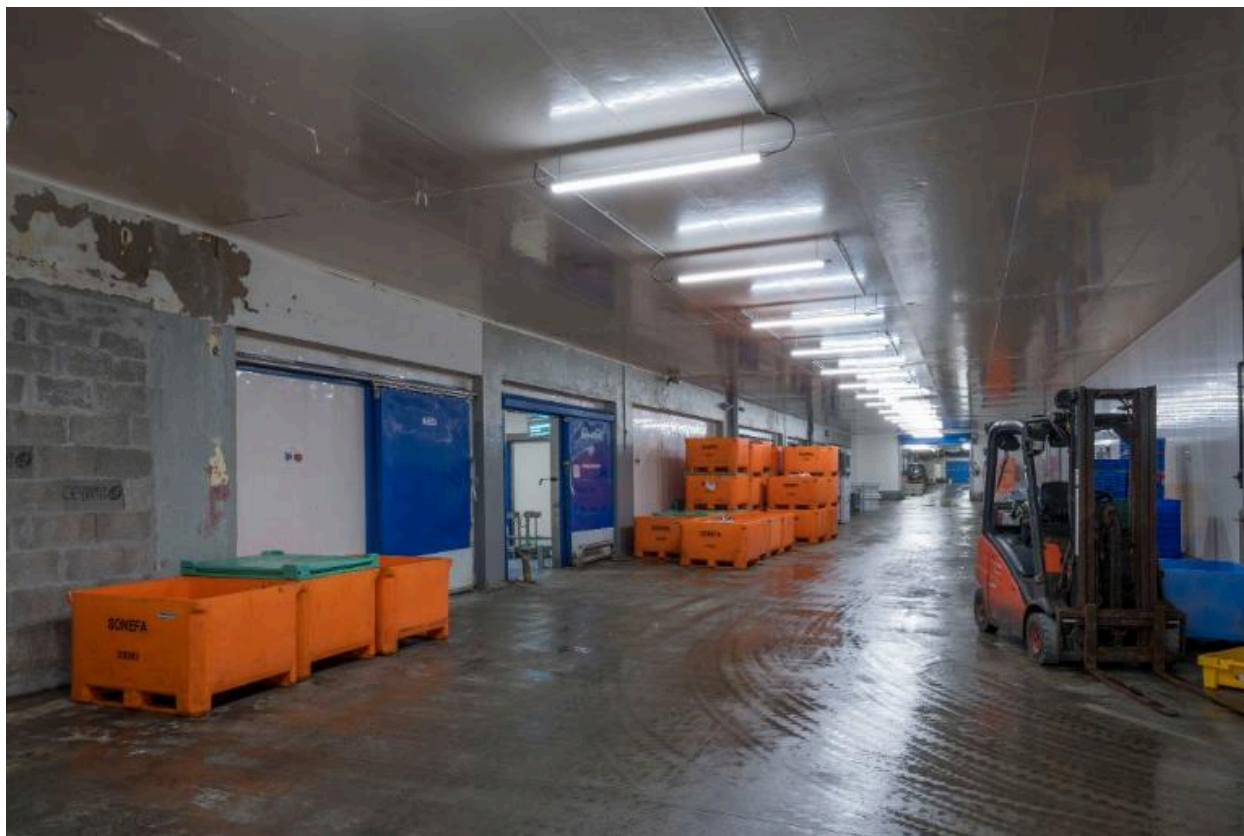
Zone de circulation et frigorifiques des mareyeurs
