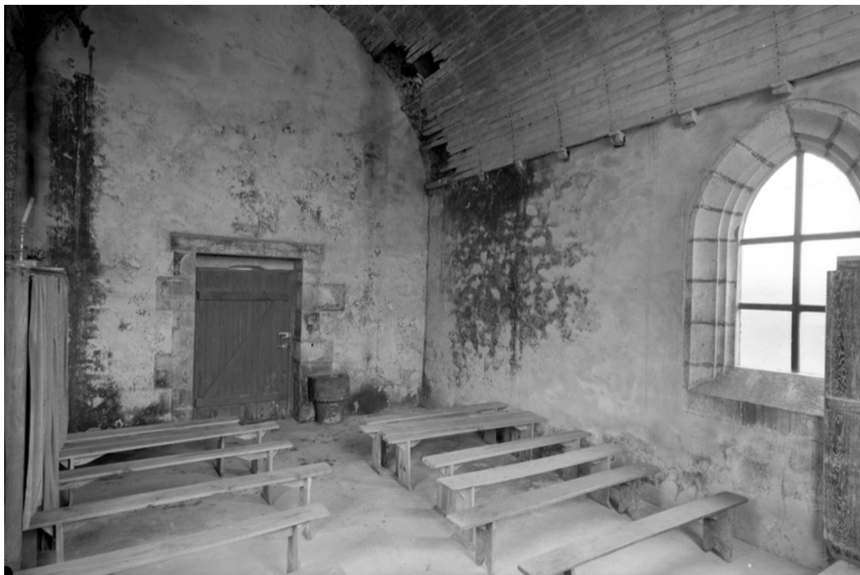
Vue générale du mur ouest et du mur nord
