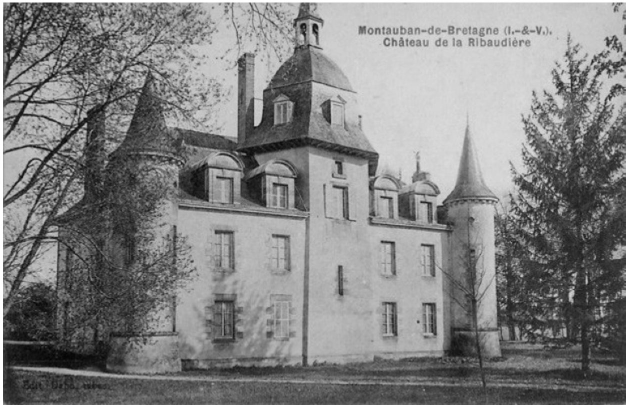
Vue générale de la façade postérieure
