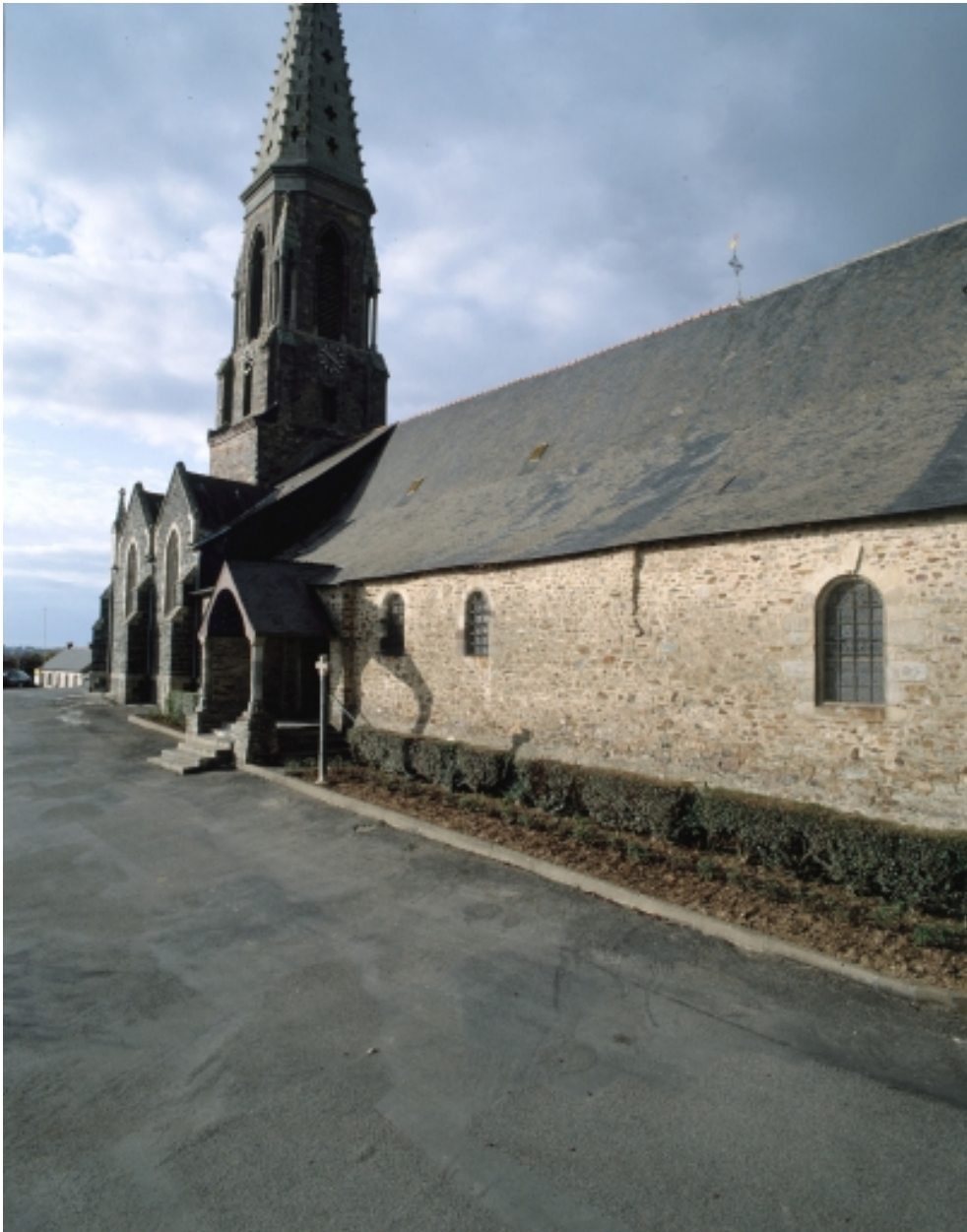
Elévation Sud-Ouest : vue générale
