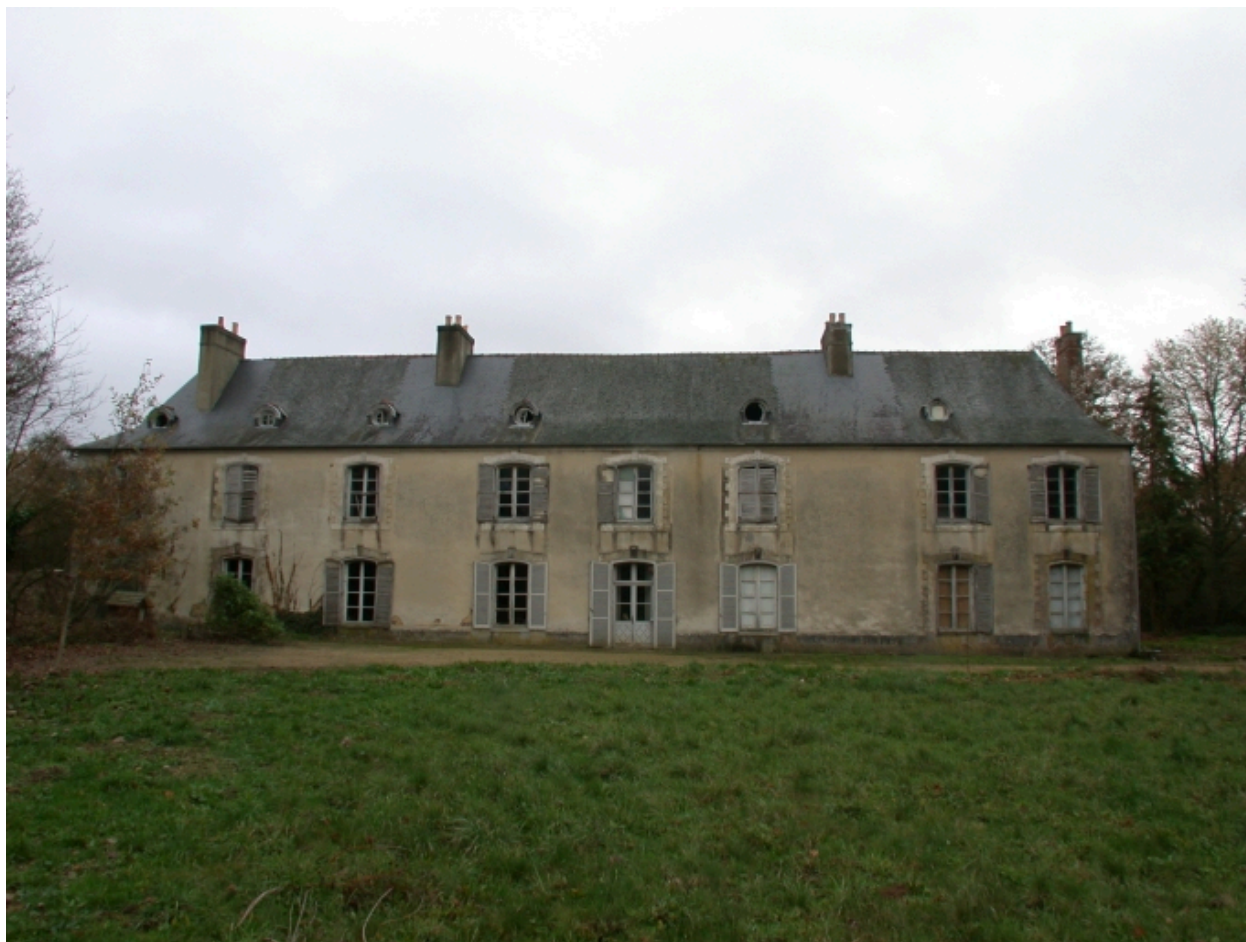
Vue générale de la façade avant
