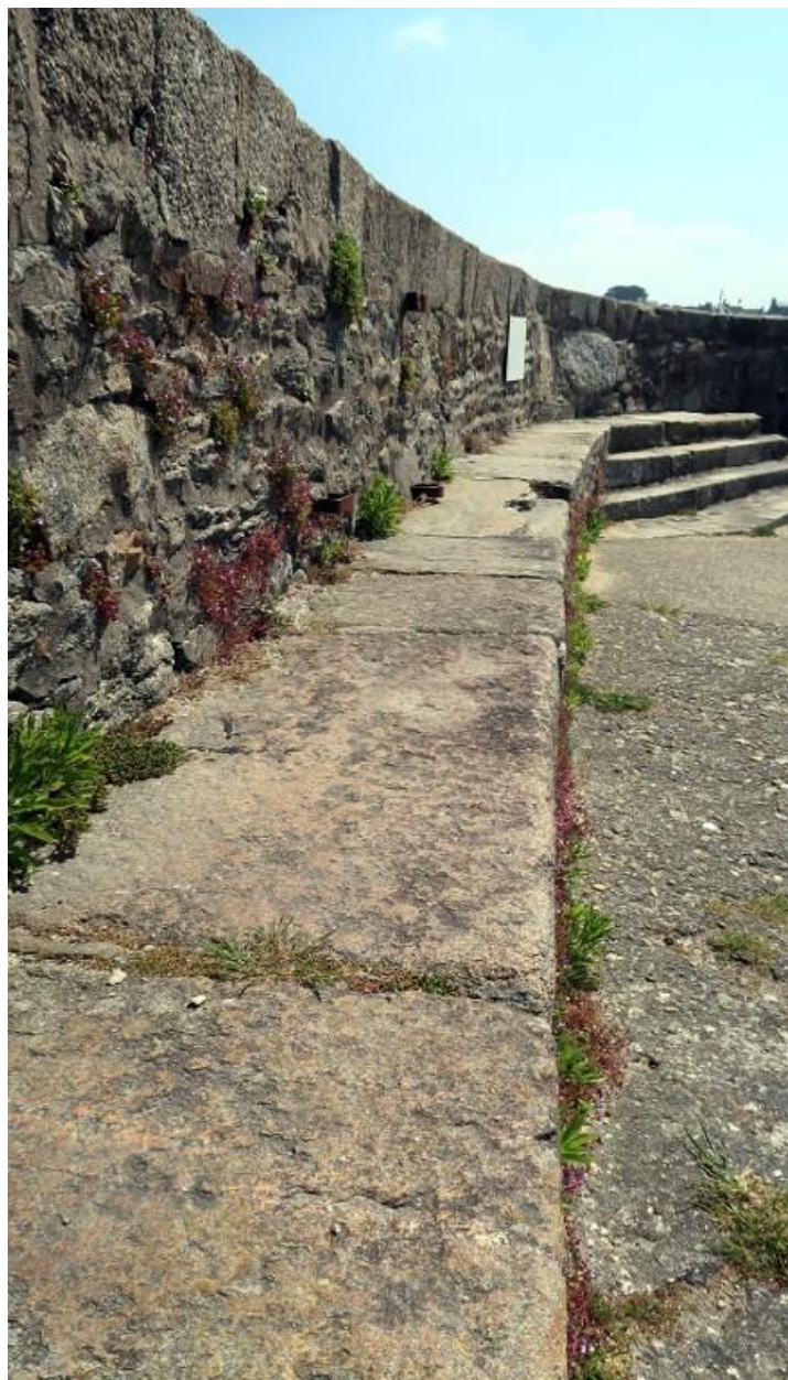
Le vieux quai du port : parapet et banquette, actuellement à usage de promenade
