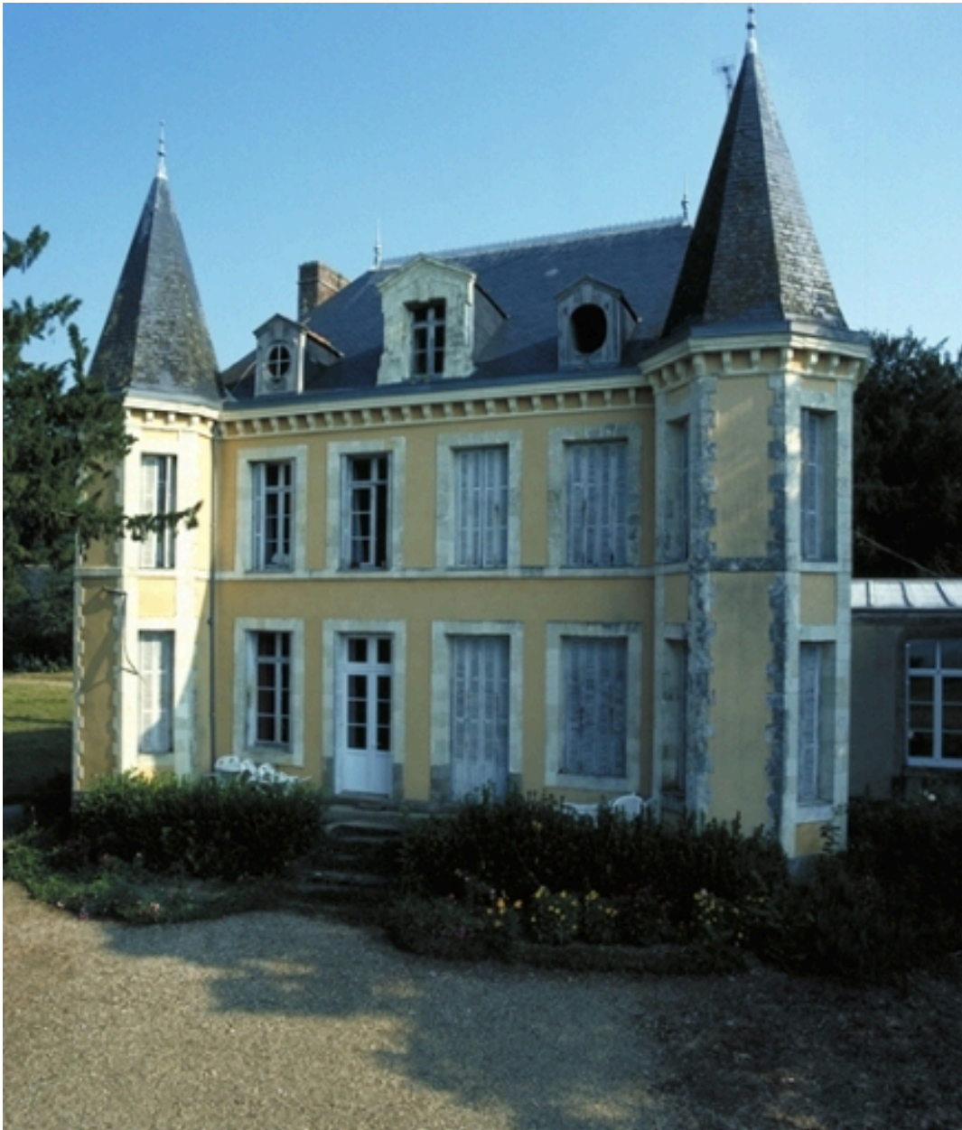
Façade sur terrasse : vue générale sud
