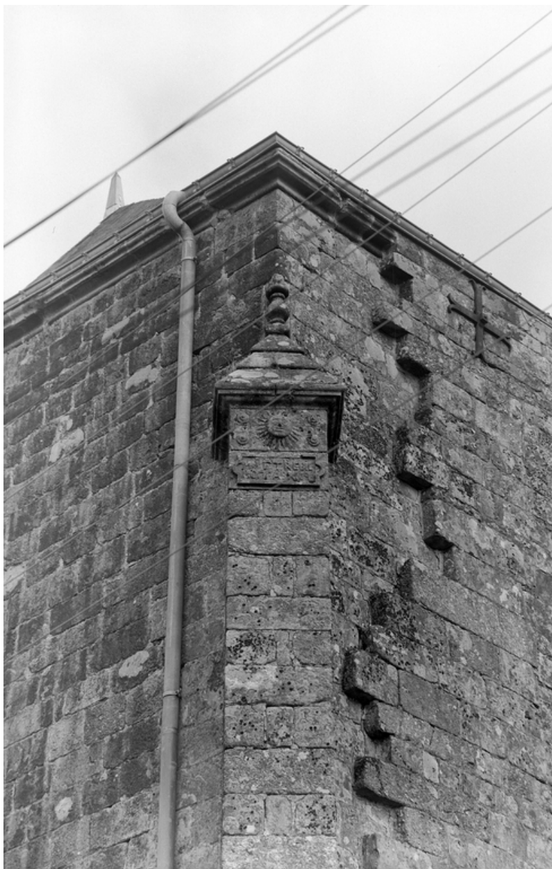
Croisillon nord, angle nord ouest : détail du contrefort
